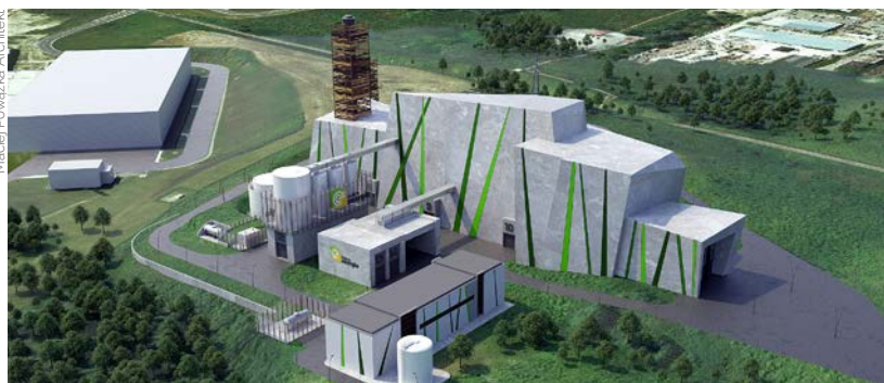
Instalacja spalać będzie frakcję palną odpadów komunalnych o średniej kaloryczności ok. 13,5 MJ/kg. Pole pracy kotła zawiera się w przedziale pomiędzy 10 a 16 MJ/kg.
